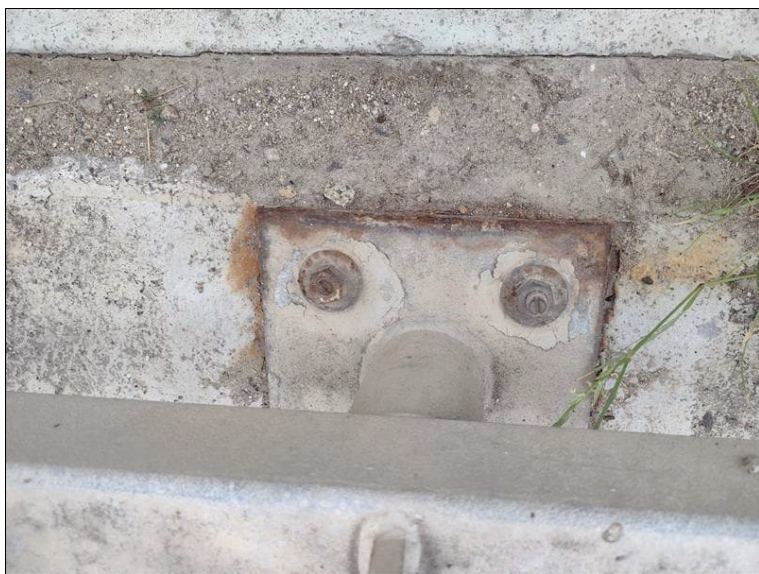
koroze kotvení zábradlí
