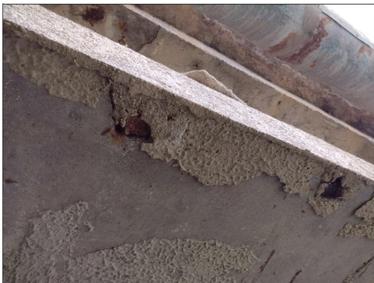
Torkretová omítka se celoplošně loupe
