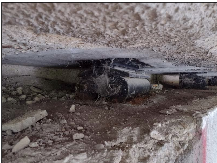
Válcové ložisko na OP4
