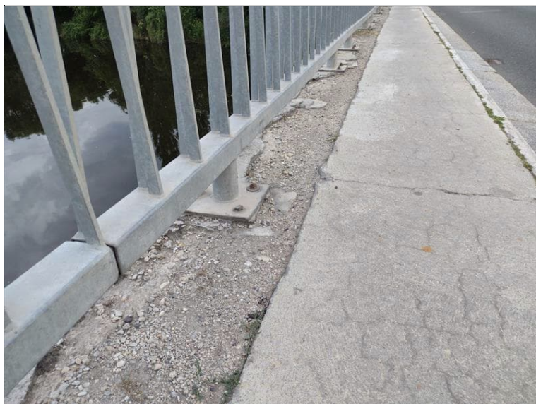
Degradace římsy
