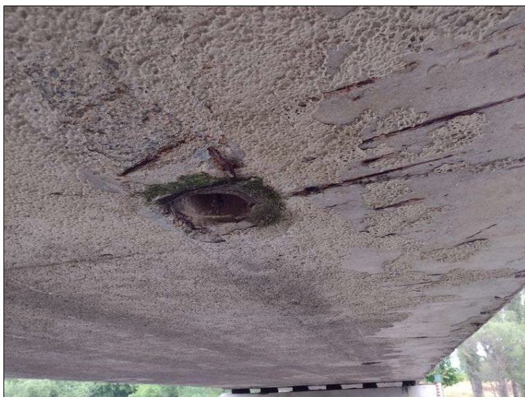
Průsaky kolem svislého svodu odvodnění na podhledu NK
