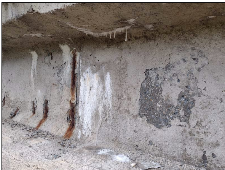
Stopy po zatékání na boku NK - pravé strana u OP4
