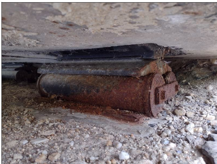
Válcové ložisko na OP4
