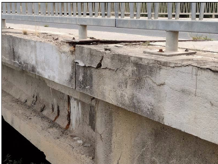
Degradace římso
