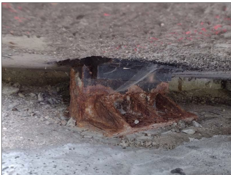
Pevné ložisko na OP1
