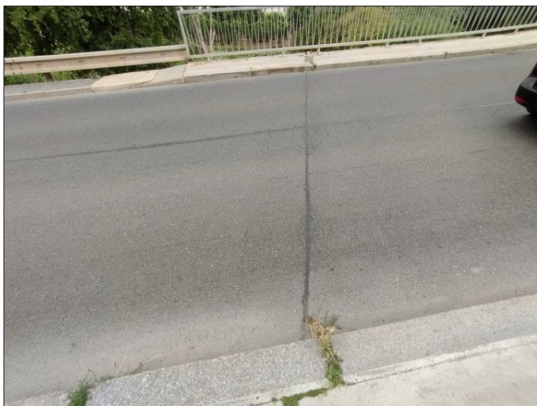
Dilatační spára ve vozovce u OP4
