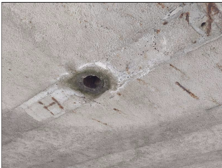
Svislý svod odvodnění na podhledu nepřesahuje přes obrys podhledu a tím dochází k zmáččení podhledu
