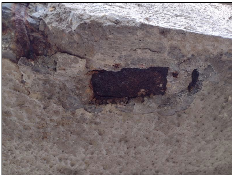
Kotva příčného předpětí
