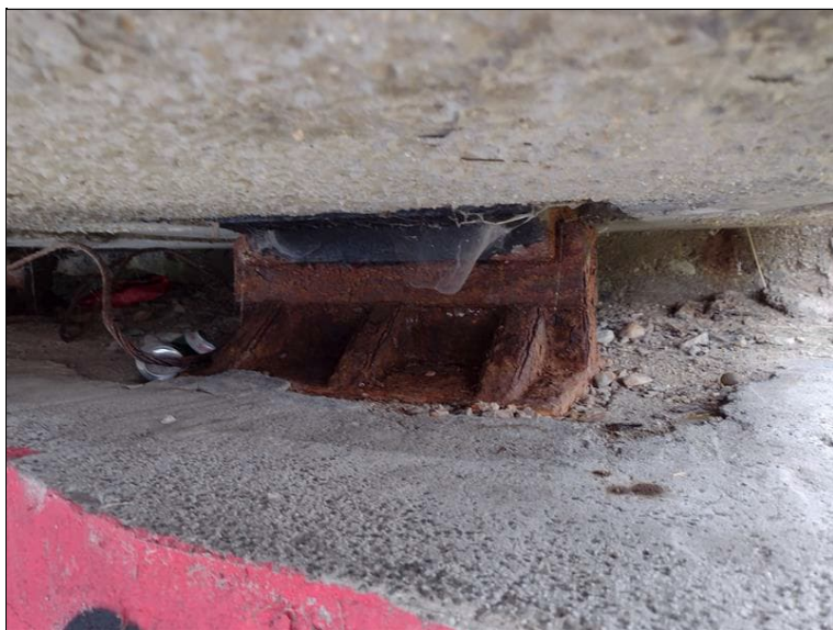
Pevné ložisko na OP1
