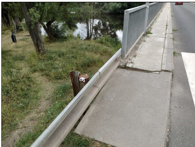
Napojení svodidla na zábradlí u OP1 vlevo
