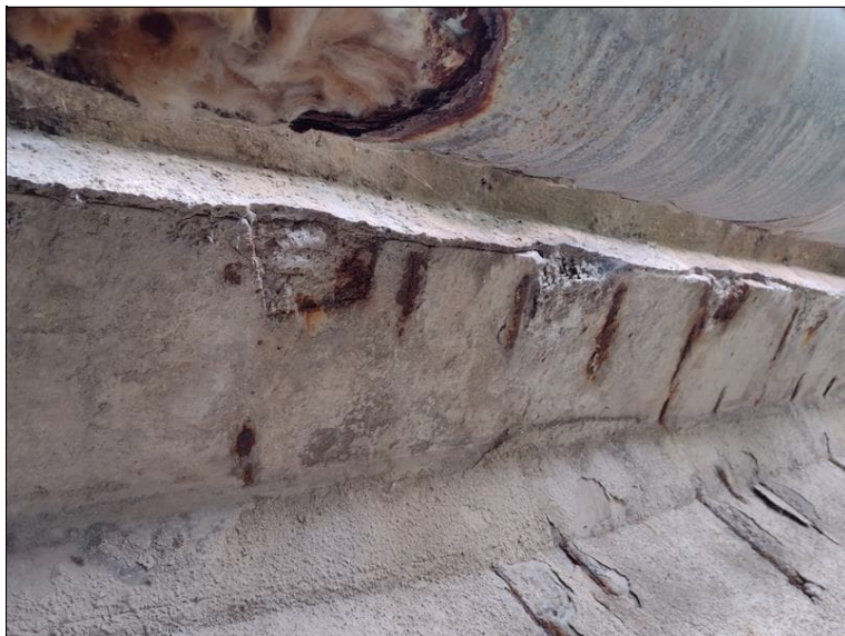
Podhled horní příruby Hn s rozpadajícím se dobetonováním kapes pro příčné předpětí
